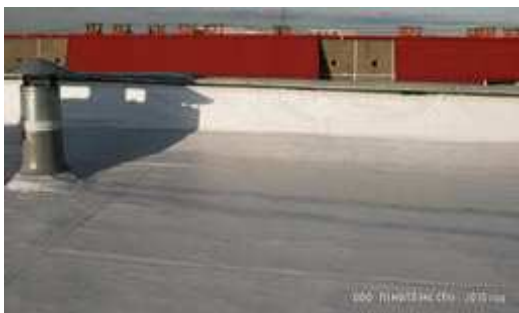
照片一、列寧格勒州基里希市無保溫層之舊瀝青屋頂修復。PLASTFOIL 材料
