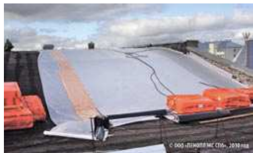
照片二、納里揚馬爾市具保溫層之舊瀝青屋頂修復。PLASTFOIL、PENOPLEKS 材料
